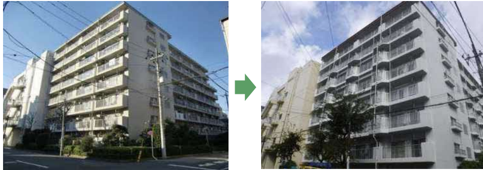
【外観（外壁塗装、耐震改修）】
