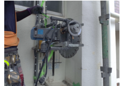
【構造スリットの施工】
