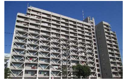
【耐震改修（制震ブレース工法）】
